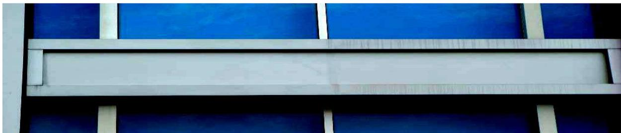
Superficie con nanocapa, descontamina el aire urbano, se auto-limpia con la lluvia evitando la adhesión del polvo y partículas PM2,5
